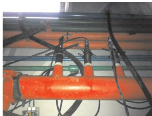
Рис. 57. Пример датчиков давления, установленных на нагнетательной линии системы манифольда буровой установки
